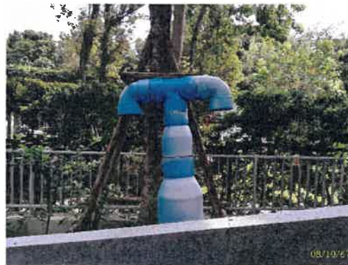
บำบัด Aerosol โดยกรองผ่านถ่าน Activated Carbon
