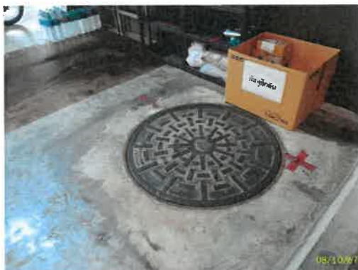
ฝาถังเก็บน้ำสำรองเพื่อการดับเพลิง ชั้นใต้ดิน
