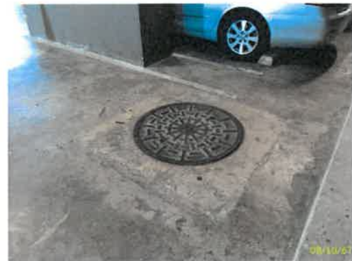
ฝาถังเก็บน้ำสำรองเพื่อการดับเพลิง ชั้นใต้ดิน
