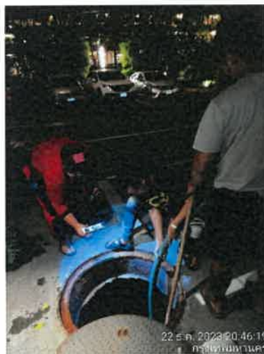
ตัดไขมัน และสูบลบตะกอนระบบบำบัดน้ำเสีย
