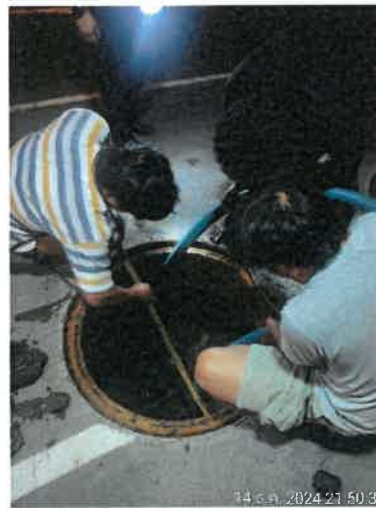
ตัดไขมัน และสูบลบตะกอนระบบบำบัดน้ำเสีย
