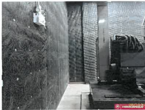
ช่องระหว่างเครื่องกำเนิดไฟฟ้าสำรองกับผนังกันเสียง
