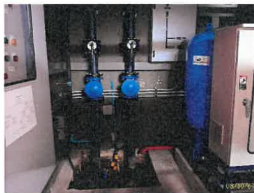
ปั๊มระบบระบายน้ำฝนชั้นใต้ดิน
